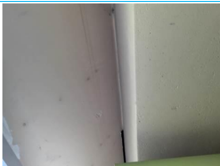
Matériaux : ZPSO-044 Prélèvement : P156 Description : Enduit de jointoiment des plaques de plâtre Localisation : Rdc - 015 Archives Résultat : Présence d'amiante
