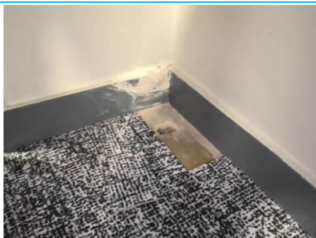
Matériaux : ZPSO-047 Prélèvement : P192 Description : Colle de carrelage beige au sol Localisation : 7ème étage - 701 Dégagement Résultat : Absence d'amiante
