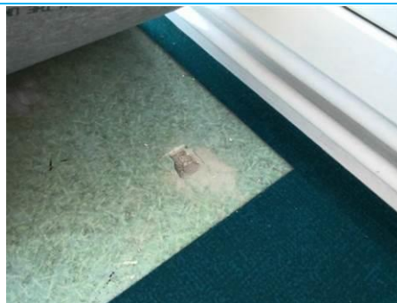
Matériaux : ZPSO-033 Prélèvement : P118 Description : Revêtement de sol vert + colle + ragréage (sous moquette) Localisation : 2ème étage - 210 Bureau Résultat : Absence d'amiante
