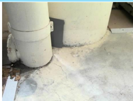
Matériaux : ZPSO-045 Prélèvement : P157 Description : Ragréage Localisation : Rdc - 015 Archives Résultat : Absence d'amiante
