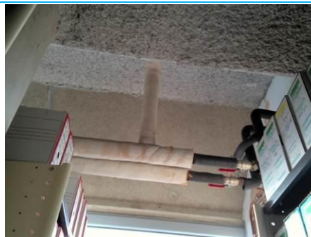
Matériaux : ZPSO-039 Prélèvement : P170 Description : Calorifugeage: laine minérale + toile plâtrée Localisation : Rdc - 004 Archives Résultat : Absence d'amiante
