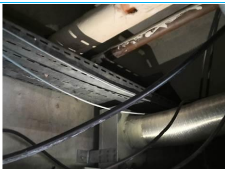
Matériaux : ZPSO-037 Prélèvement : P220 Description : Joint gris souple sur conduits de ventilation Localisation : 4ème étage - 416 Equipe FICOE Résultat : Absence d'amiante
