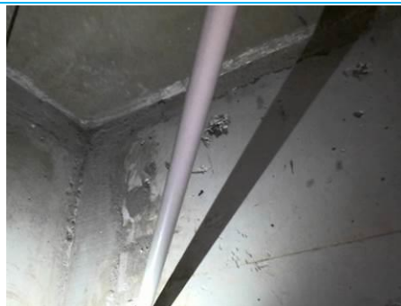
Matériaux : ZPSO-036 Prélèvement : P134 Description : Mur: enduit de lissage en ciment Localisation : 2ème étage - 201 Circulation noyau Résultat : Absence d'amiante
