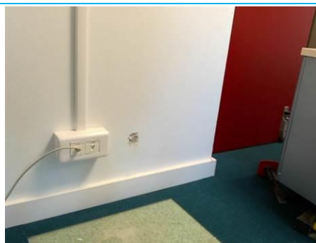
Matériaux : ZPSO-016 Prélèvement : P127 Description : Mur sur dégagement: tapisserie + enduit + peinture sur béton Localisation : 2ème étage - Circulation 220 Résultat : Absence d'amiante
