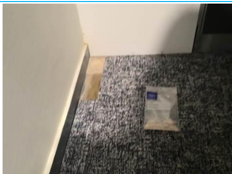
Matériaux : ZPSO-047 Prélèvement : P212 Description : Colle de carrelage beige au sol Localisation : 1er étage - 103 Tisanerie Résultat : Absence d'amiante
