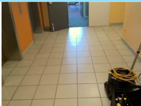
Matériaux : ZPSO-049 Prélèvement : P200 Description : Colle de carrelage gris au sol Localisation : 8ème étage - 801 Dégagement Résultat : Absence d'amiante
