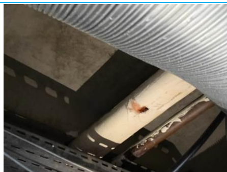
Matériaux : ZPSO-039 Prélèvement : P221 Description : Calorifugeage: laine minérale + toile plâtrée Localisation : 4ème étage - 416 Equipe FICOE Résultat : Absence d'amiante
