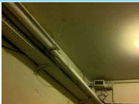
Matériaux : ZPSO-039 Prélèvement : P167 Description : Calorifugeage: laine minérale + toile plâtrée Localisation : Rdc - 008 Local poubelles Résultat : Absence d'amiante
