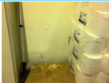
Matériaux : ZPSO-035 Prélèvement : P168 Description : Mur: plâtre + peinture Localisation : Rdc - 008 Local poubelles Résultat : Absence d'amiante
