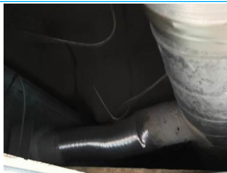
Matériaux : ZPSO-037 Prélèvement : P219 Description : Joint gris souple sur conduits de ventilation Localisation : 2ème étage - 212 Com CRE Résultat : Absence d'amiante
