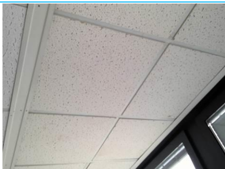
Matériaux : ZPSO-021 Prélèvement : P098 Description : Faux-plafond blanc avec motifs Localisation : 4ème étage - 422 Circulation Résultat : Absence d'amiante
