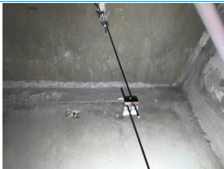
Matériaux : ZPSO-036 Prélèvement : P133 Description : Mur: enduit de lissage en ciment Localisation : 2ème étage - 201 Circulation noyau Résultat : Absence d'amiante
