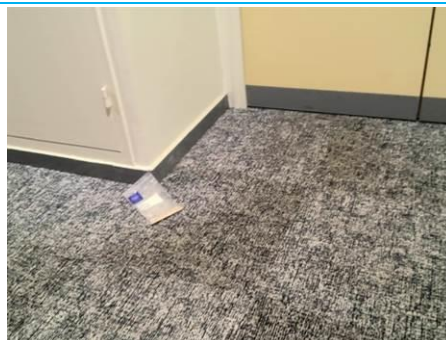
Matériaux : ZPSO-047 Prélèvement : P213 Description : Colle de carrelage beige au sol Localisation : 1er étage - 101 Circulation noyau Résultat : Absence d'amiante
