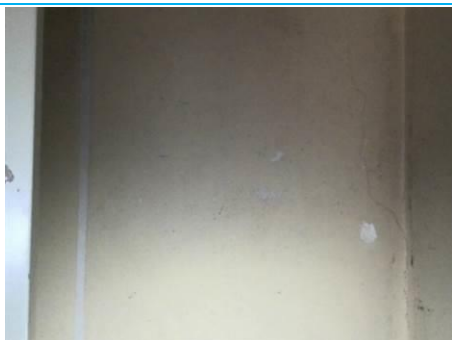
Matériaux : ZPSO-035 Prélèvement : P131 Description : Mur: plâtre + peinture Localisation : 2ème étage - 203 Local ménage Résultat : Absence d'amiante
