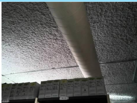
Matériaux : ZPSO-042 Prélèvement : P169 Description : Flocage Localisation : Rdc - 004 Archives Résultat : Absence d'amiante
