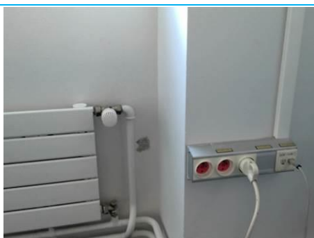
Matériaux : ZPSO-015 Prélèvement : P120 Description : Mur sur extérieur : plâtre + peinture sur béton Localisation : 2ème étage - 210 Bureau Résultat : Absence d'amiante
