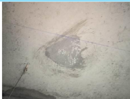
Matériaux : ZPSO-048 Prélèvement : P195 Description : Plafond : Enduit de lissage ciment Localisation : 7ème étage - 701 Dégagement Résultat : Absence d'amiante
