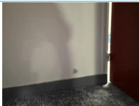
Matériaux : ZPSO-020 Prélèvement : P197 Description : Mur: Enduit sur béton Localisation : 7ème étage - 701 Dégagement Résultat : Absence d'amiante
